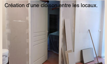
Création d'une cloison entre les locaux.
