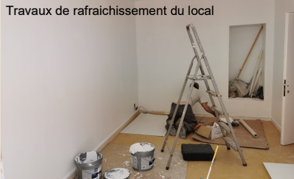
Travaux de rafraîchissement du local
