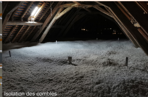
Isolation des combles
