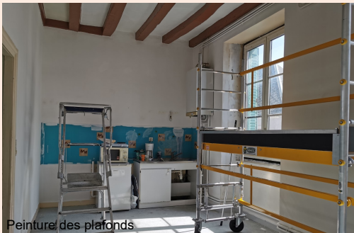
Peinture des plafonds
