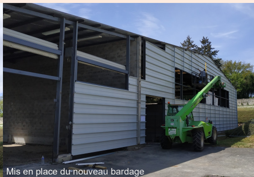
Mis en place du nouveau bardage
