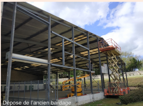
Dépose de l'ancien bardage
